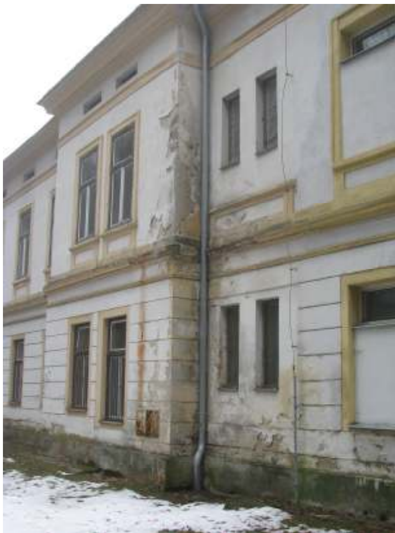
Prepad okapných chodníkov a pôdy okolo objektu a poškodenie muriva vodou.
