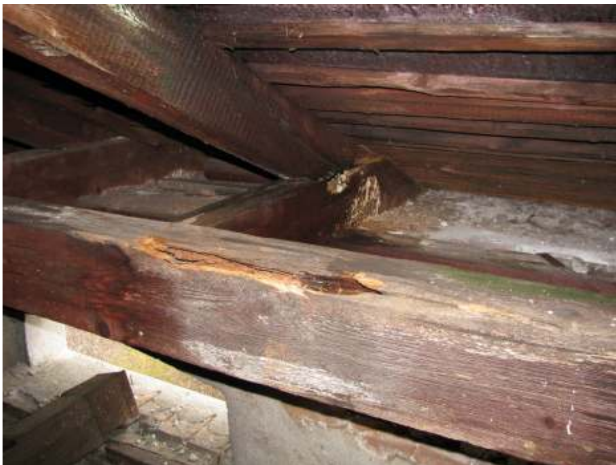
Poškodenie krovu zatekaním.
